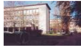
ENSM site de Nantes 1 rue de la Noë Bat C 44300 NANTES
