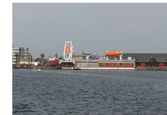
CESAME Quai du val Terre-plein des Servanais 35400 SAINT-MALO
