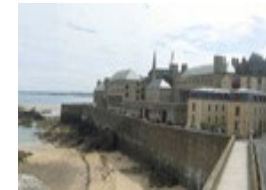
ENSM Site de Saint Malo 38 rue croix désilles 35400 SAINT-MALO
